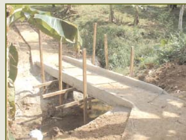
Febrero 2004. Construcción de puente peatonal sobre cauce en la ciudad de El Castillo.
