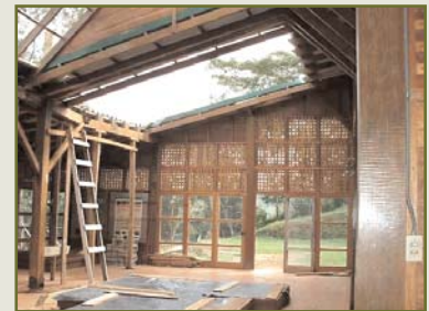
Diciembre 03. Desmontaje de los lucernarios del Centro de Interpretación de El Castillo
