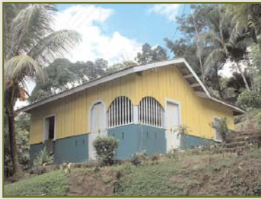
Septiembre 2004. Casas de El Castillo atendidas por el programa de vivienda antes y después de la intervención
