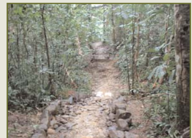
Octubre 2004. Obras de consolidación de la travesía del sendero Bartola
