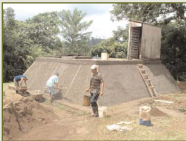
Septiembre 2004. Trabajos de impermeabilización exterior de las pilas de agua
